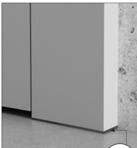
Szczelinę wypełniamy uszczelniaczem.
